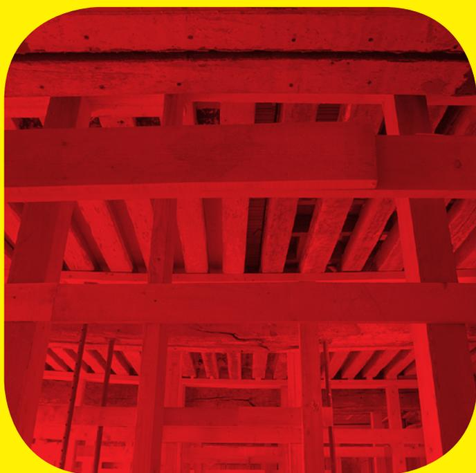
La transformation des structures bois porteuses, verticales ou horizontales (charpentes, solivages plancher, pan de bois) doit être envisagée avec précaution.
